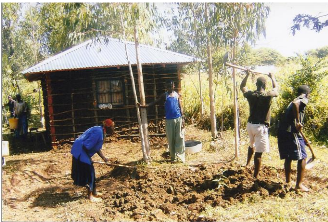
Der erste Neubau ist beinahe vollendet
