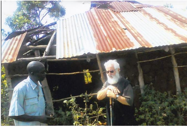
Bruder Josef bespricht mit Baumeister Jakob den nächsten Bauabschnitt
